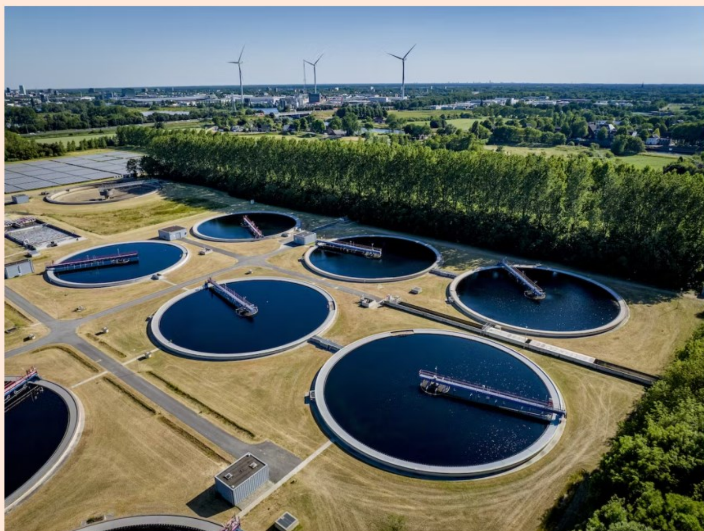
Waterzuiveringsinstallatie rwzi in Den Bosch. ANP / Robin Utrecht
