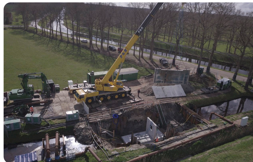
Figuur 14: Gemeente Coehoorn, pilot prefab en losmaakbaar bouwen in geopolymerbeton
