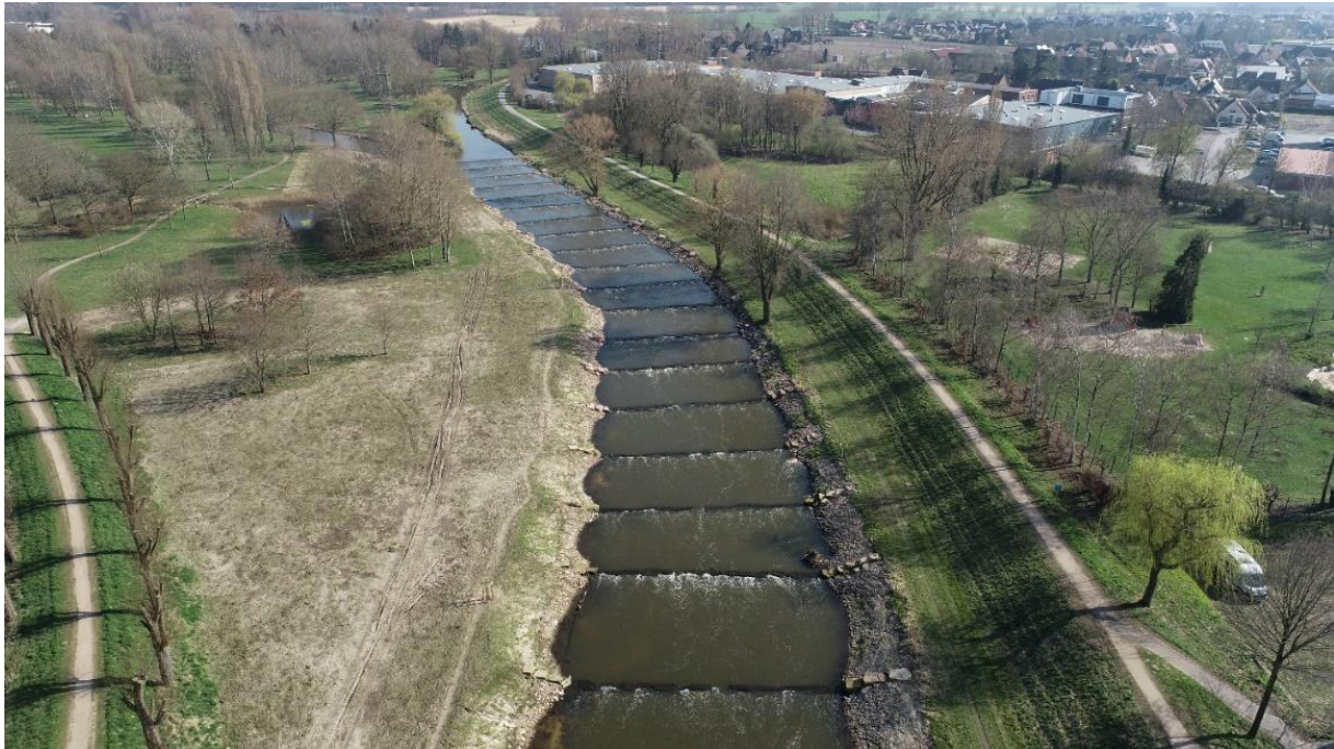
Nieuwe cascdestuw met geïntegreerde vistrap in de Vecht bij Schüttorf.
